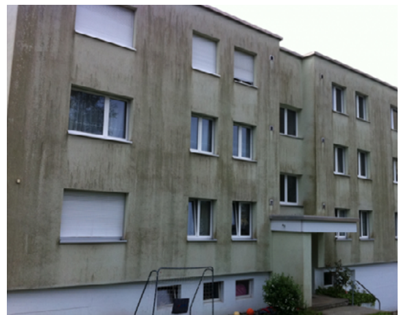
Рис. 37: Образование водорослей на системах внешней теплоизоляции. Источник: ВВР
