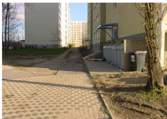
Рис. 49: Продольная сторона здания с нанесенным красочным покрытием и модернизацией стыков гидрошпонками; козырьки над задними входами. Источник: ВВР
