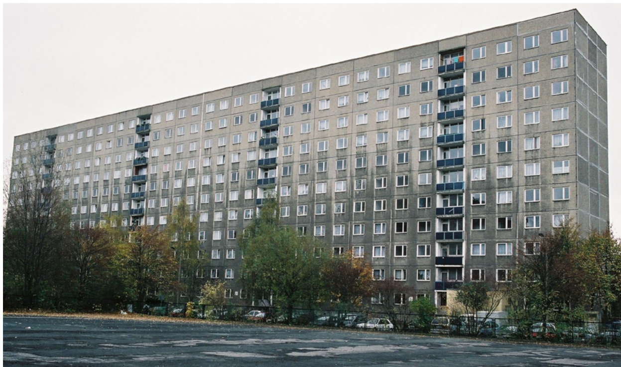
Рис. 71: Панельное здание P2/11 до модернизации
