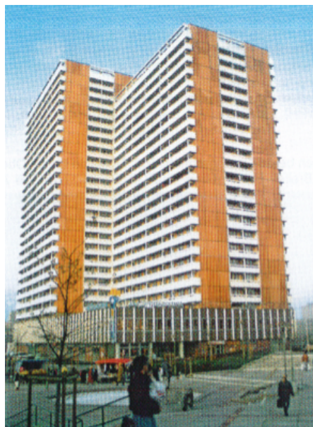
Рис. 8: Жилой дом каркасной конструкции серии WHH SK. Источник: ВВР
