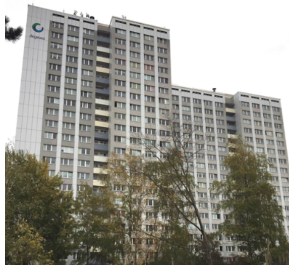
Рис. 22: Комбинированный фасад с применением систем ETICS и Rainscreen; жилой высотный дом серии WHH GT. Источник: ВВР
