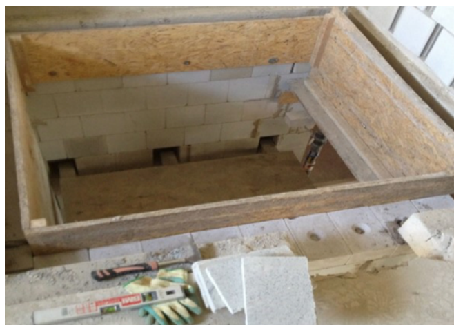
Рис. 25: Более позднее создание проёма для шахты лифта в здании. Источник: ВВР
