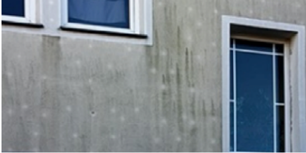
Рис. 38: Проявление расположения дюбелей на фасаде. Источник: ВВР
