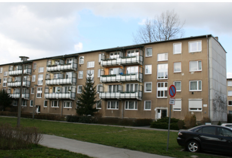
Рис. 3: Здание серии Q3A с последующей изоляцией его торца; фактическое состояние. Источник: ВВР
