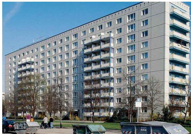
Рис. 4: Модернизация здания серии QP 64 в центральном районе Берлина с сохранением его архитектурного облика. Источник: ВВР
