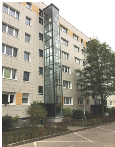
Рис. 24: Более поздняя установка лифта перед лестничной клеткой. Источник: ВВР
