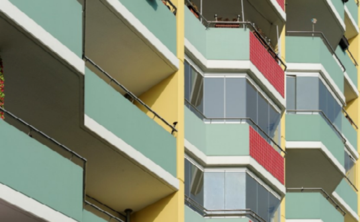
Рис. 23: Обновлённые лоджии в железобетонном варианте. Источник: ВВР
