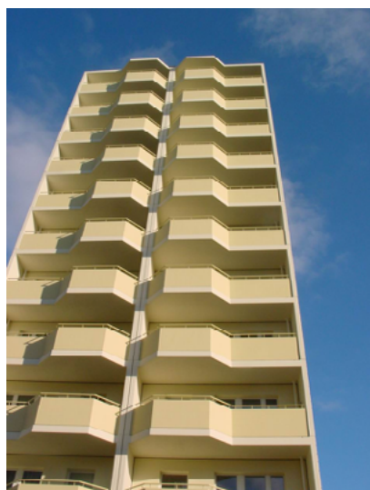
Рис. 48: 11-этажное здание серии WBS 70 по окончании первой модернизации, в частности, обновления лоджий и замены окон. Источник: ВВР
