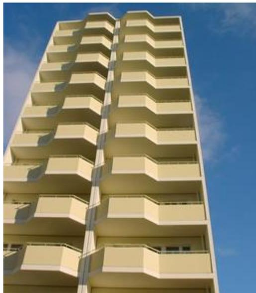
Abbildung 48: 11-geschossiges WBS-70-Gebäude nach abgeschlossener erster Sanierung, u. a. erfolgte eine Loggiaerneuerung und ein Fensteraustausch. Quelle: BBP.
