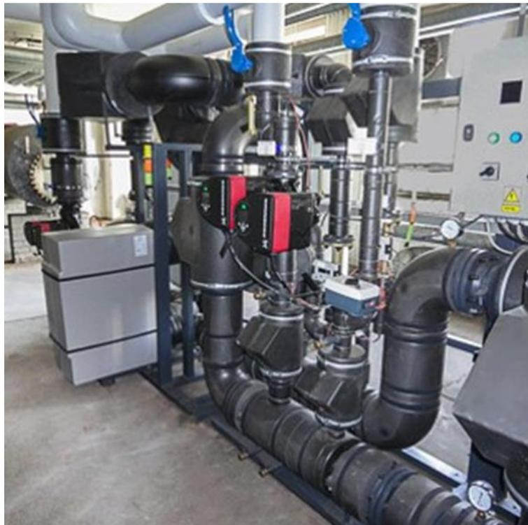
Abbildung 43: Moderne und effiziente Hausanschlussstation für Fernwärme. Quelle: BBP.
