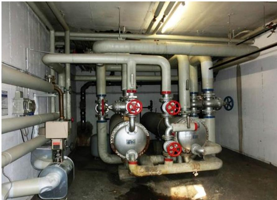
Abbildung 18: Fernwärmeübergabestation mit zwei Röhrenwärmetauschern für die Trinkwarmwasserbereitung. Quelle: BBP.
