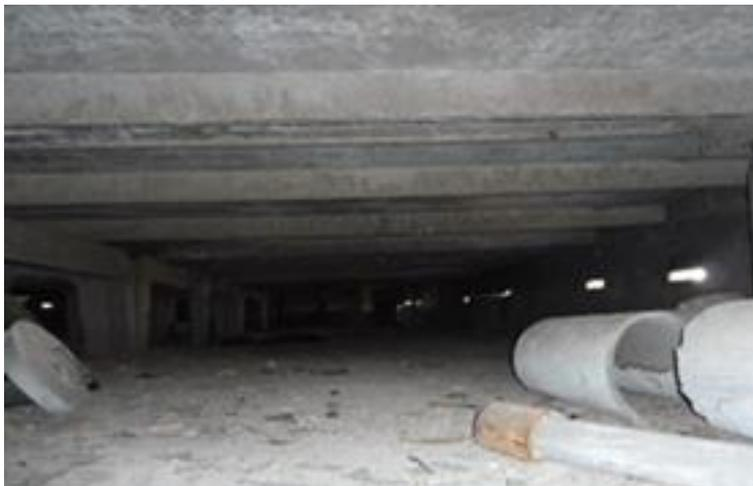
Abbildung 107: Im Drenpel – Dämmung fehlt, vermüllt.
