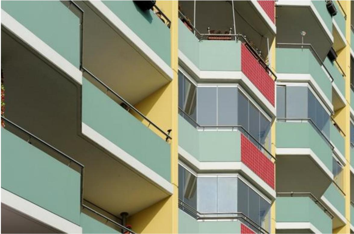
Abbildung 23: Erneuerte Loggien in Stahlbetonausführung. Quelle: BBP.
