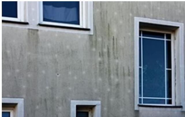
Abbildung 38: Die Anordnung der Dübel zeichnet sich auf einer Fassade ab. Quelle: BBP.
