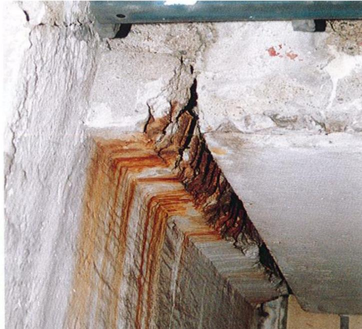
Abbildung 14: Stark korrodiertes Auflager einer Loggiadecke; Serie P2-11. Quelle: BBP.
