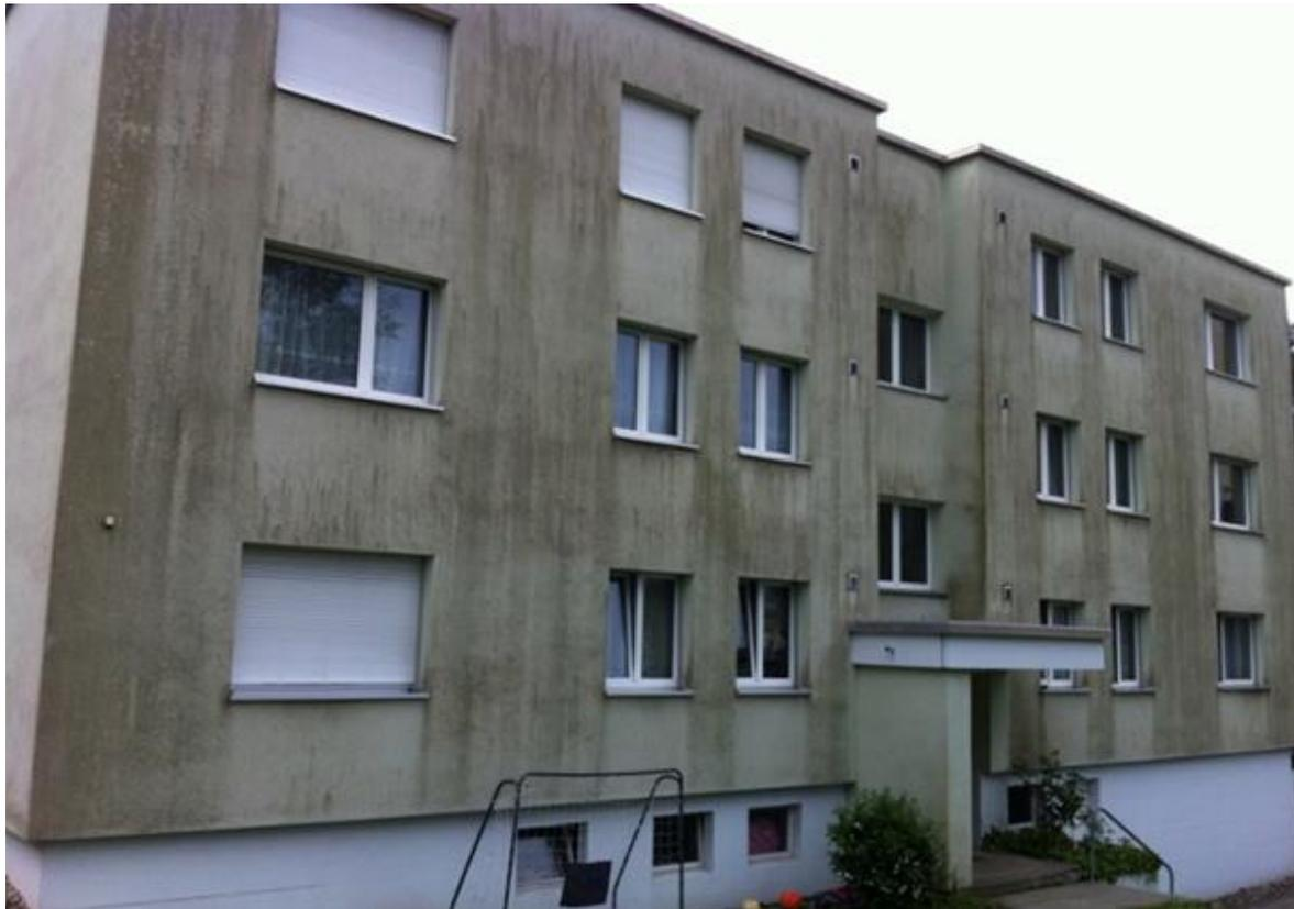
Abbildung 37: Algenbildung auf Wärmedämmverbundsystemen. Quelle: BBP.
