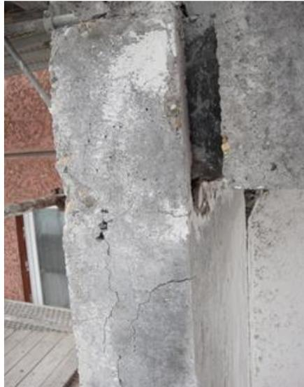
Abbildung 10: Netzartige Rissbildung in einer Loggiaseitenwand; Serie WBS 70-11 infolge einer Alkali-Kieselsäure-Reaktion. Quelle: BBP.
