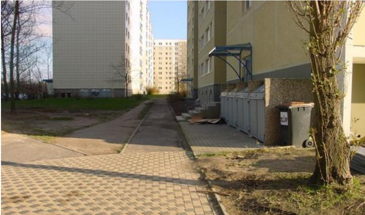
Abbildung 49: Gebäudelängsseite mit Farbanstrich und Sanierung der Fugen mittels Fugenbändern; Überdachung des Hintereinganges. Quelle: BBP.
