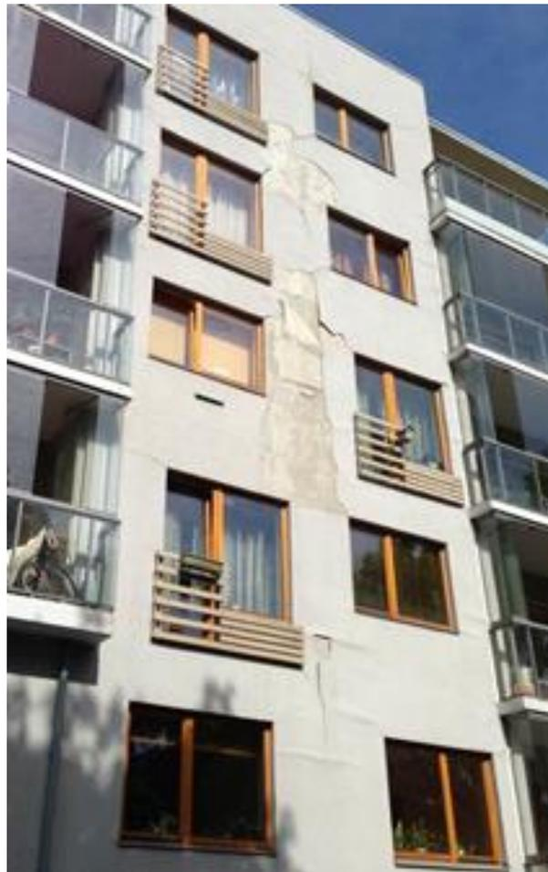
Abbildung 40: Extreme Putzschäden bei einer überdämmten Bewegungsfuge. Quelle: BBP.
