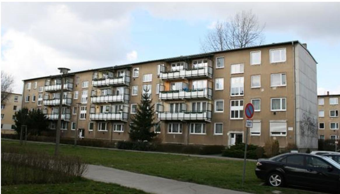
Abbildung 3: Q3A-Gebäude im Ist-Zustand; nachträglich gedämmter Giebel. Quelle: BBP.
