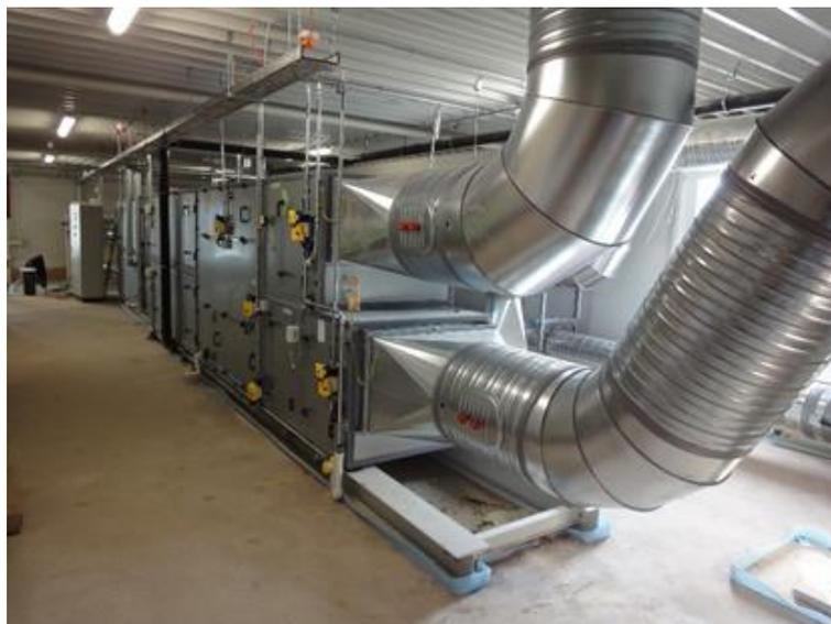
Abbildung 92: In der Lüftungszentrale: Anlage mit Wärmerückgewinnung. Haus Binzengrün, Freiburg.
