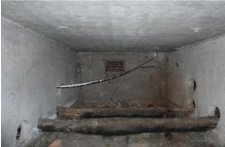
Abbildung 106: Rohre im Keller – funktionsuntüchtige Rohrdämmung.
