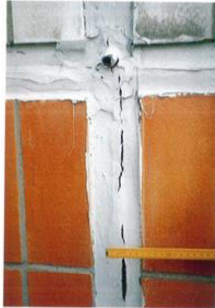
Abbildung 16: Versprödeter und gerissener Fugenkitt; Serie QP. Quelle: BBP.
