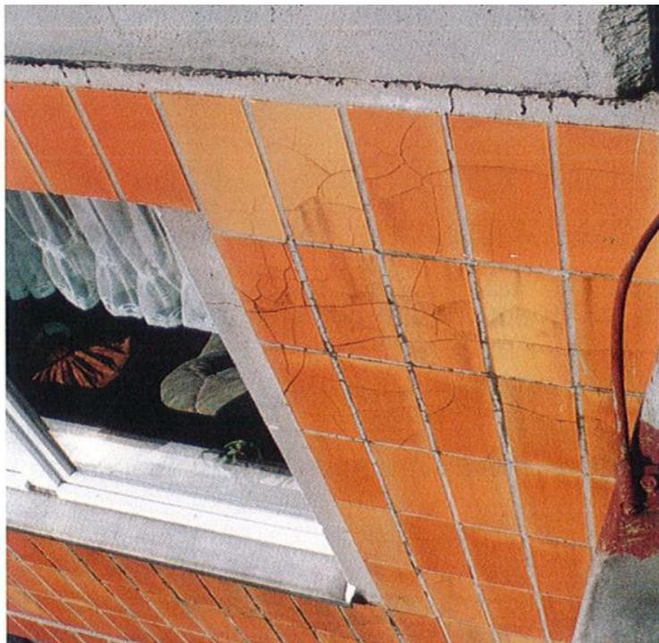
Abbildung 15: Stark gerissene Keramikbekleidung; Serie QP. Quelle: BBP.
