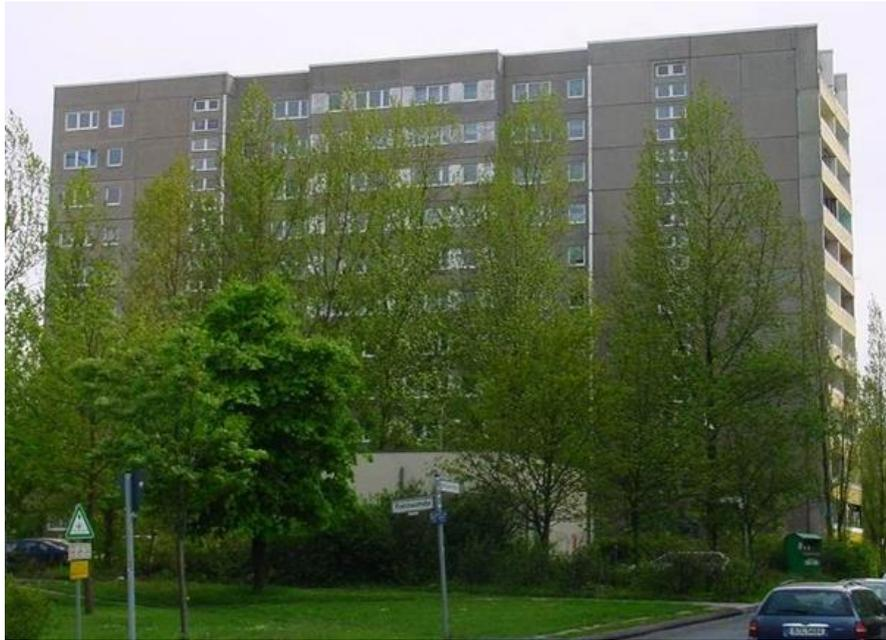
Abbildung 47: 11-geschossiges WBS-70-Gebäude im Ist-Zustand. Quelle: BBP.
