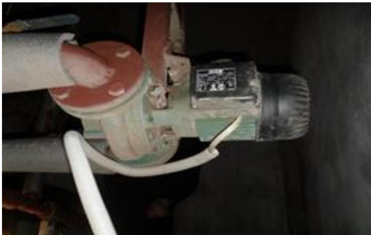
Abbildung 105: Heizungskomponente – ungedämmt.
