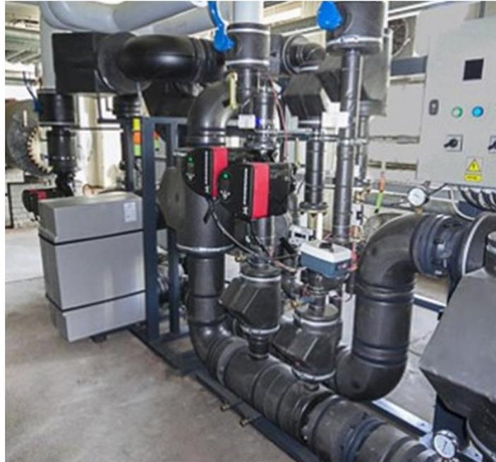
Abbildung 26: Modernisierte Hausanschlussstation; Fernwärmeversorgung. Quelle: BBP.
