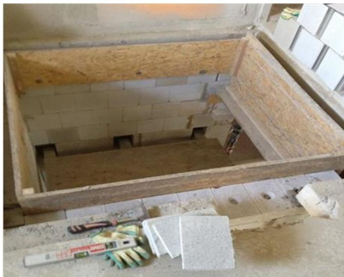
Abbildung 25: Nachträgliche Einbringung einer Aussparung für den Aufzug im Gebäude. Quelle: BBP.
