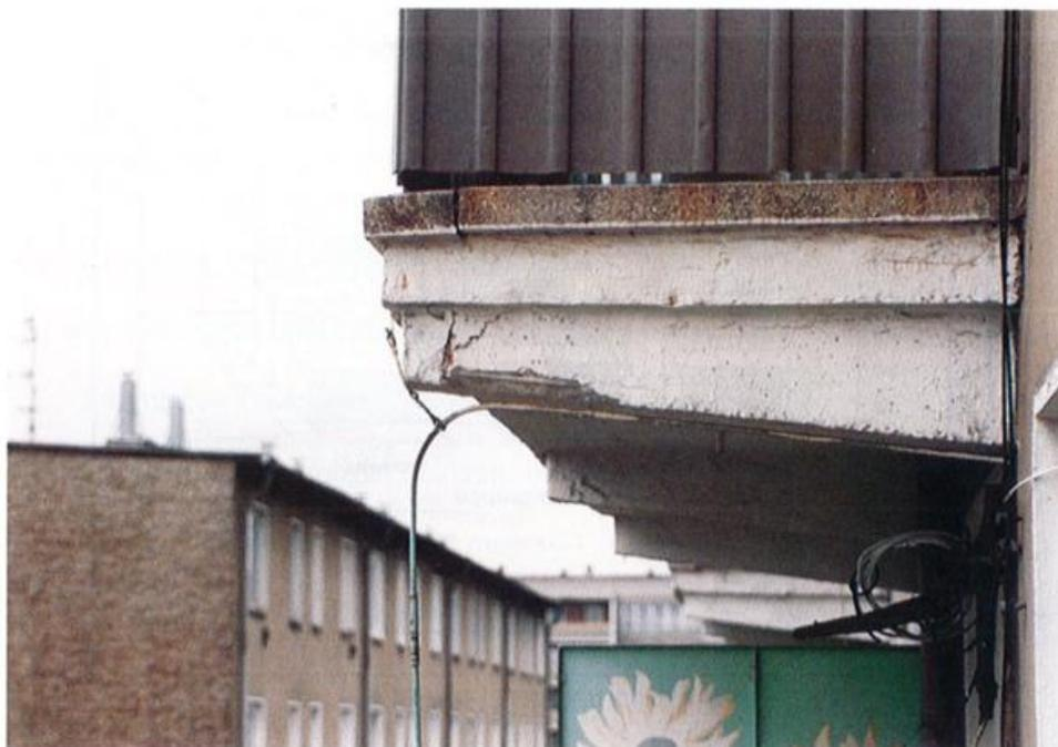
Abbildung 12: Geschädigte Auflagerkonsole einer Balkonplatte; Serie Q3A. Quelle: BBP.
