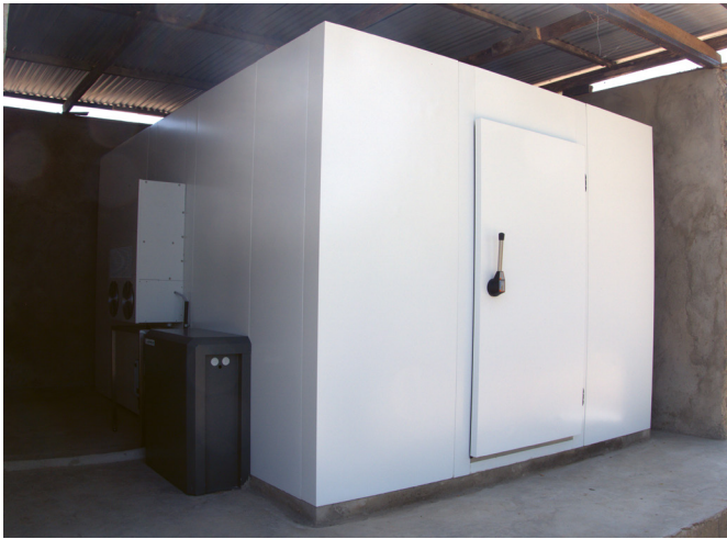
l.: Kühlraum und Kühlaggregat – Cold storage room and refrigeration unit ; r.: Feierliche Übergabe des Schlüssels an Herrn Muuo vor der CELLUX-Anlage – Ceremonial handover of the key to Mr. Muuo in front of the CELLUX plant.
