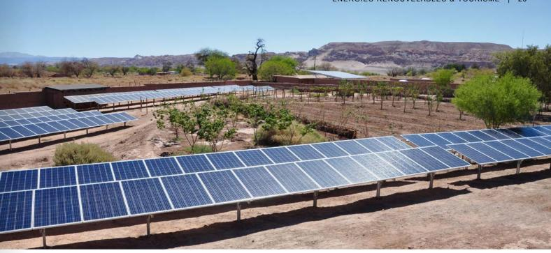
sur batteries et les groupes électrogènes. Une gestion intelligente des divers composants du système permet à l'hôtel de couper ses groupes électrogènes la journée durant huit à neuf heures, et la nuit durant plusieurs heures. Cet investissement, disposant d'une période d'amortissement de six ans, réduit considérablement les coûts d'achat de gazole, les émissions de gaz à effet de serre et le bruit ; pour un hôtel de luxe, il s'agit là d'avantages significatifs.
