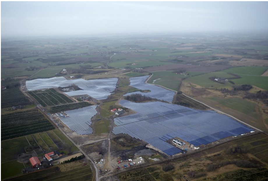
Abbildung 27: Weltweit größtes solarthermisches Kollektorfeld in Silkeborg mit 156.694 m 2 . Das Netz versorgt 4.400 Haushalte (mit freundlicher Genehmigung von Arcon-Sunmark)
