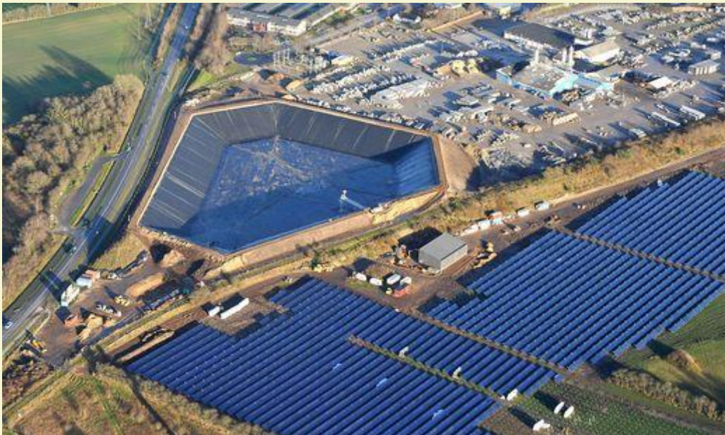
Abbildung 4: Solarspeicher und Kollektorfeld in Vojens (mit freundlicher Genehmigung von Arcon-Sunmark)
