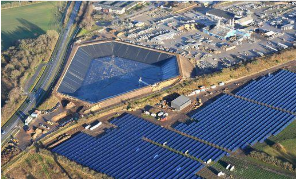
Abbildung 31: Solarspeicher und Kollektorfeld in Vojens (Bildquelle: Lago Laumark Möller)
