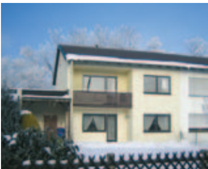
Abb. 8: Doppelhaushälfte aus den 1970er Jahren
