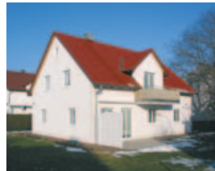
Abb. 10: Modernes verputztes Fertighaus aus den 1990er Jahren
