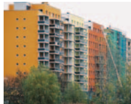
Abb. 15: Plattenbau von 1973, links saniert, rechts während der Sanierung 2004
