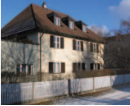
Abb. 6: Wohnhaus aus den 1930er Jahren
