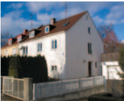
Abb. 7: Einfaches Wohnhaus aus den 1950er Jahren
