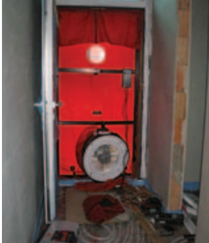
Abb. 39: Vorbereitung eines Luftdichtheits-tests an einer Außentür
