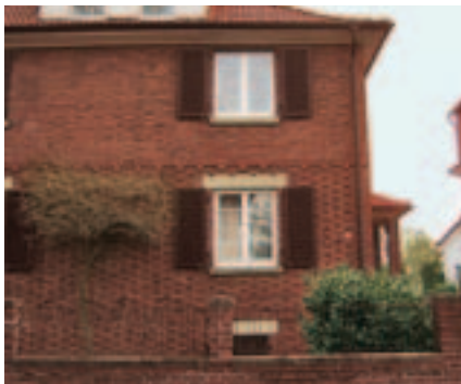
Abb. 35: Backsteinfassade mit sichtbarem Fenstersturz aus Beton
