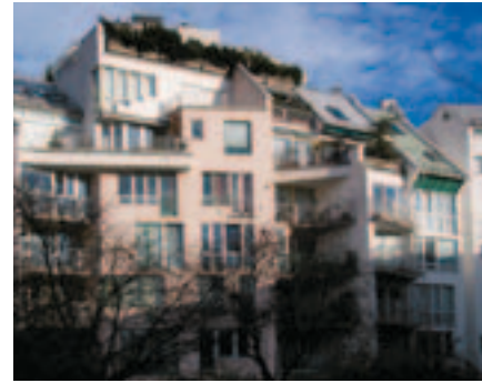
Abb. 14: Mehrfamilienhaus aus den 1980er Jahren
