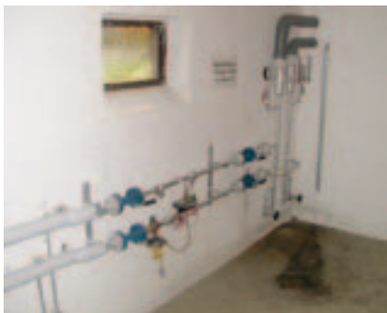
Abb. 45: Fernwärme-Übergabestation: direkte Übergabe ohne Tauscher
