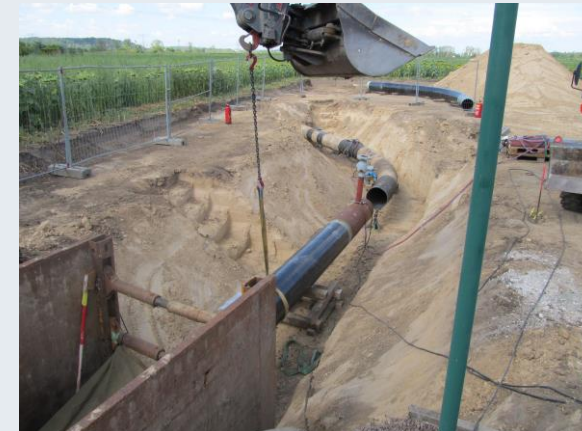
Entnahme von Rohrproben zur Festigkeitsanalyse
