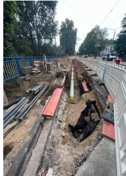
Verleger Rohrleitungsabschnitt
