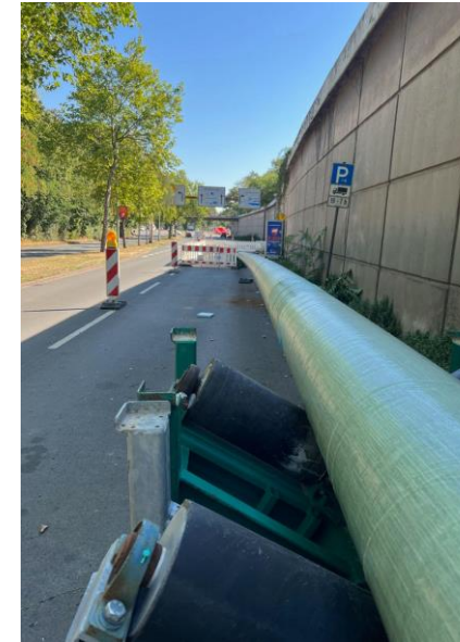
Vorfertigung Rohrleitungsabschnitt
