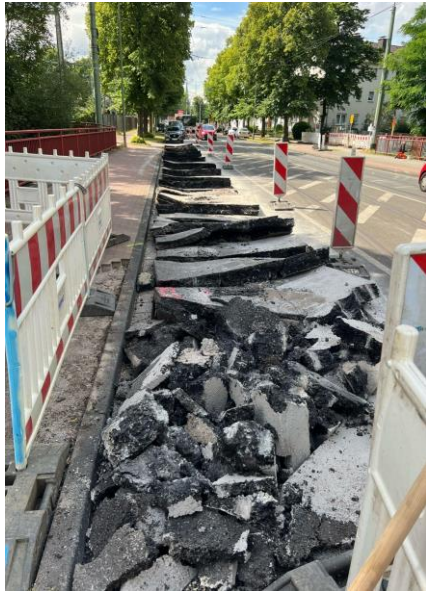
Vorbereitung Oberfläche (Straßenöffnung)
