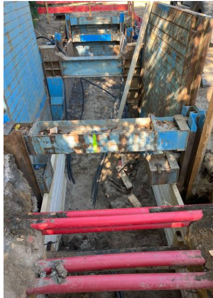
Herstellung Rohrgraben (mit existierenden Fremdkörpern)
