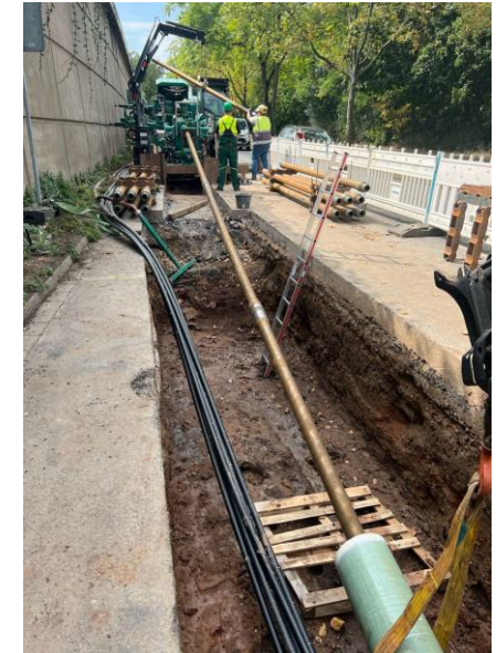
HDD-Verfahren in Arbeit
